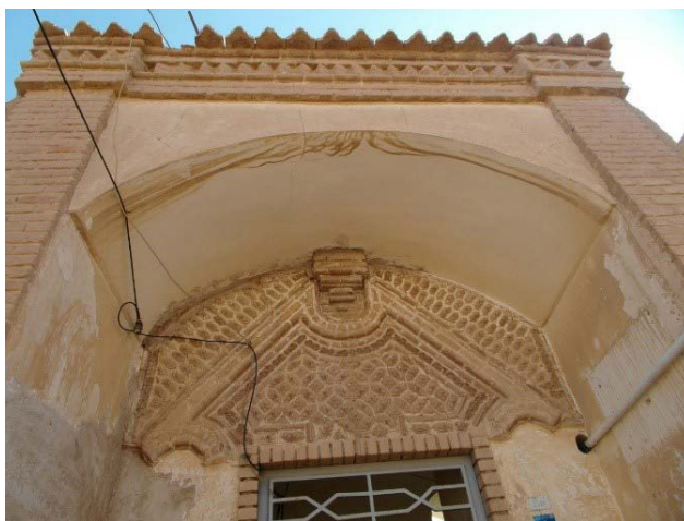
تصویر ۱۴. دو نمونه از تزئینات آجرکاری قالبی سردر ورودی خانه‌های غفاری و تاجور (نگارندگان، ۱۳۹۳).
