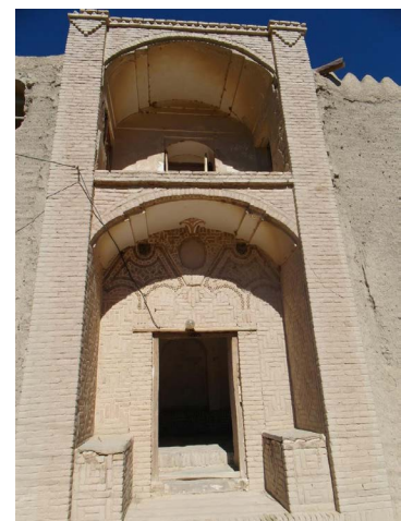
تصویر ۱۴. دو نمونه از تزئینات آجرکاری قالبی سردر ورودی خانه‌های غفاری و تاجور (نگارندگان، ۱۳۹۳).
